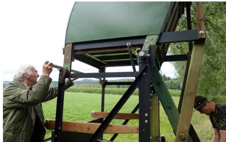
Jetzt muss noch die Front mit einer Stahlstange gesichert werden, schon ist die Reindl bezugsfertig.
